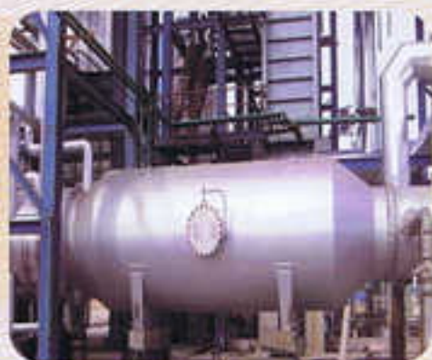
酸性气焚烧炉
