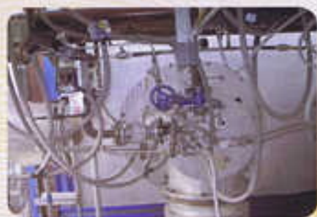
燃烧器布置现场
