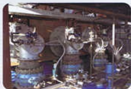
燃烧器施工中
